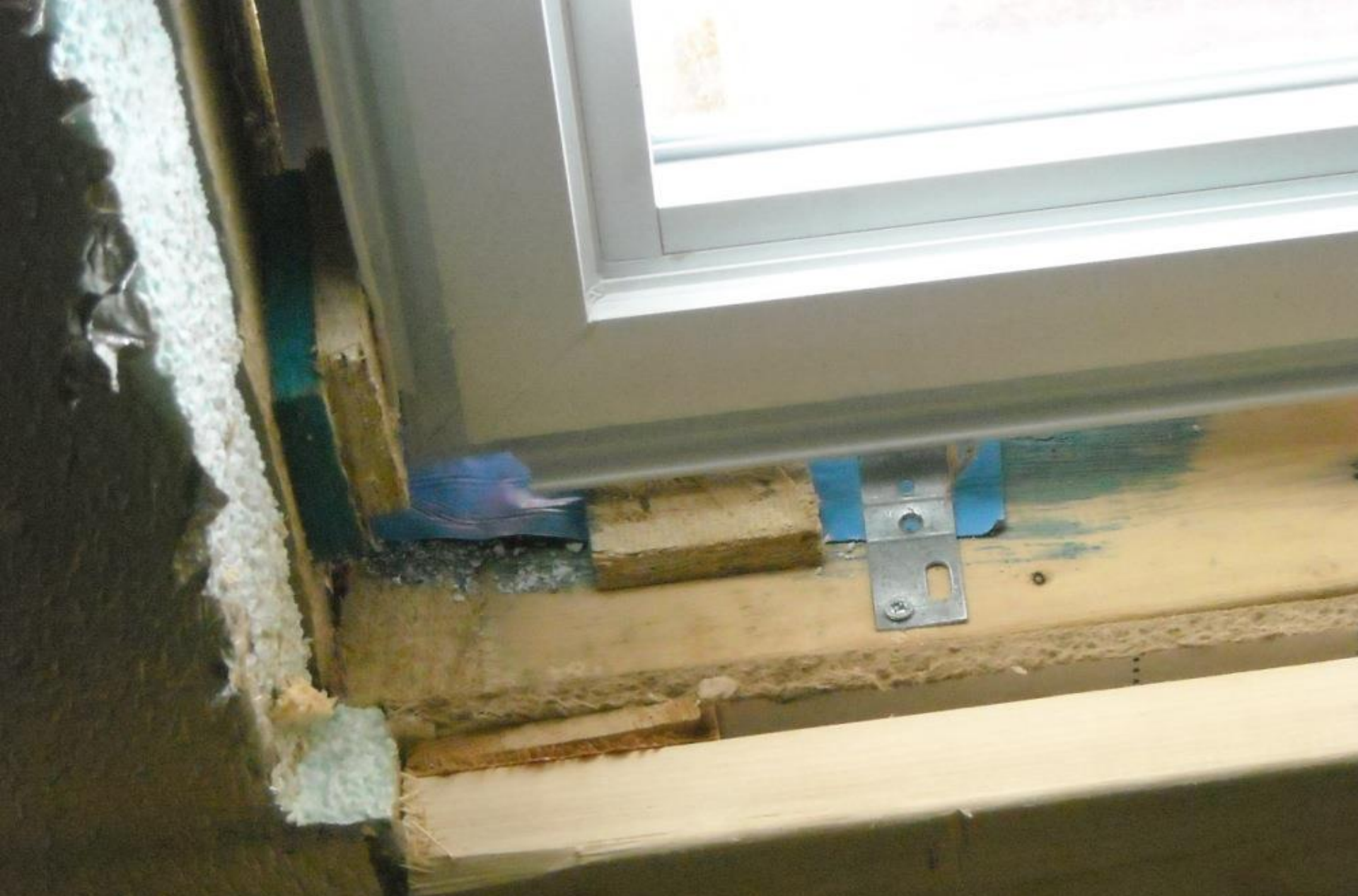
Pre-fijación de ventanas
