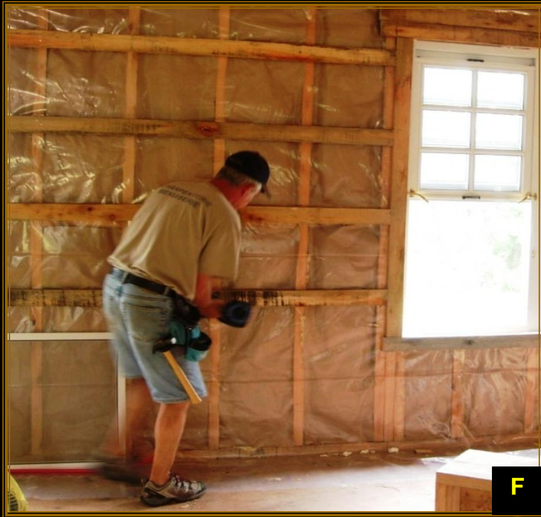
F.- Fijación - listones en muros para revestimiento interior
