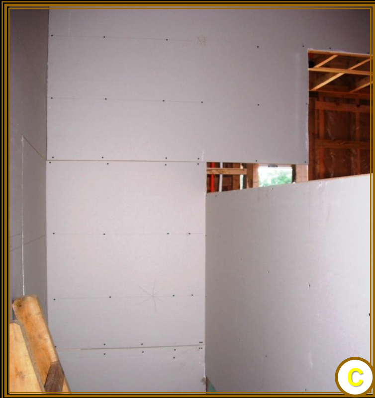
C.- Espacio de escaleras
