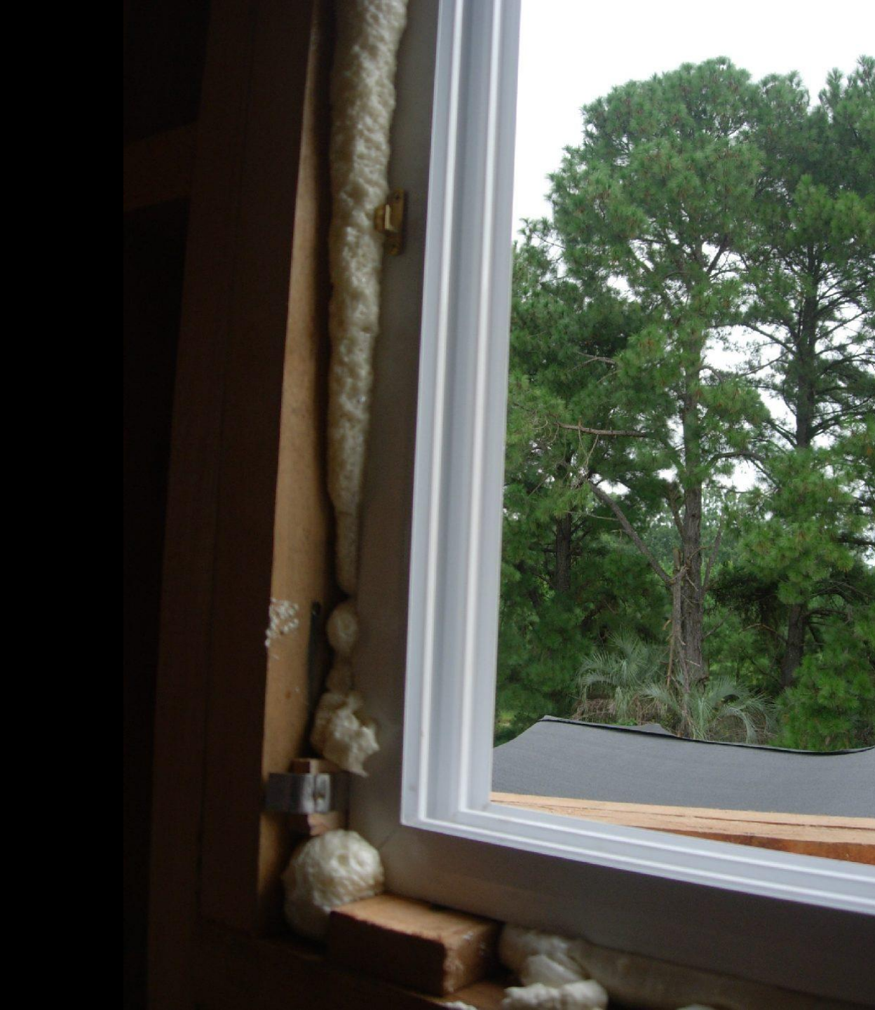
Sellado y fijación Con espuma de poliuretano
