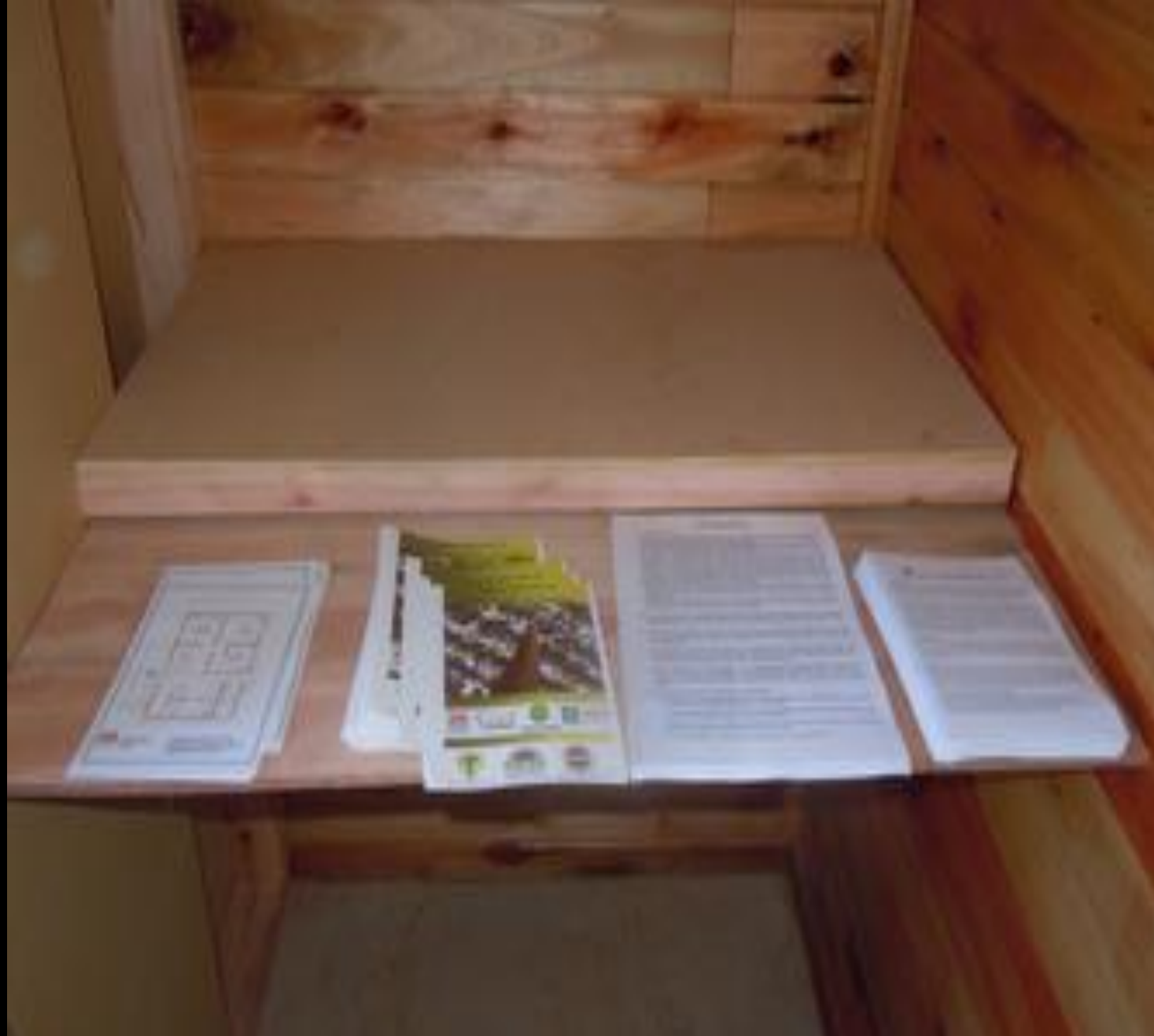
Estantes usando estructura de la pared
