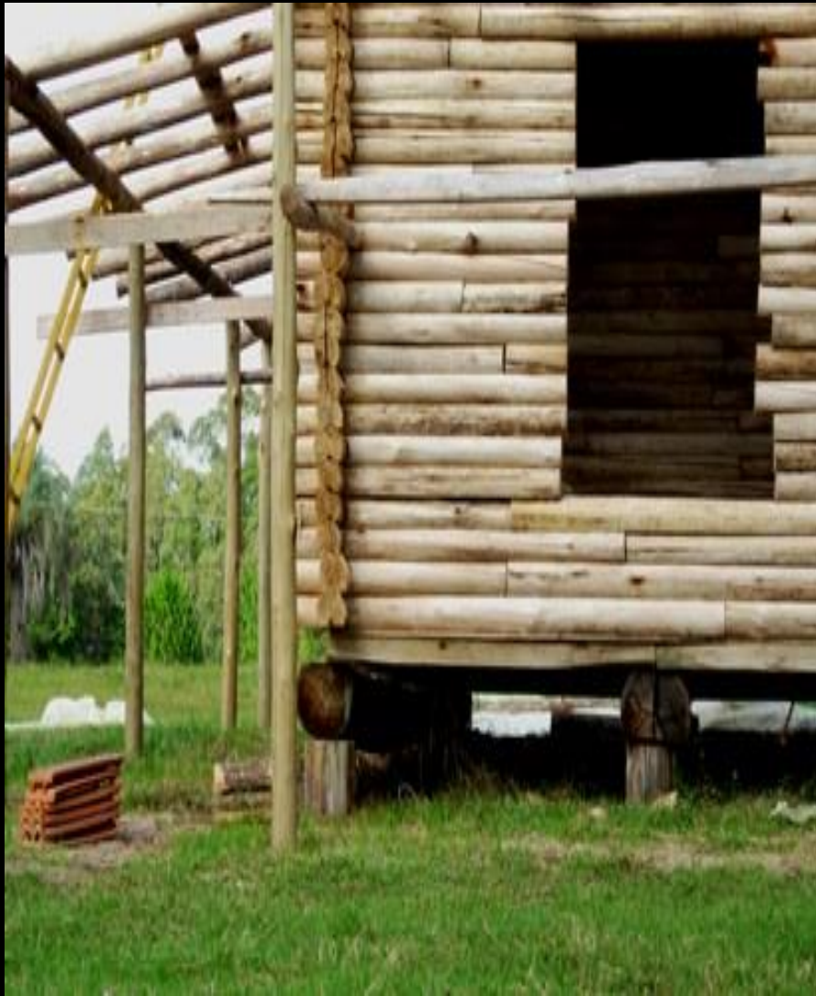
Aislación de piso Con trineos
