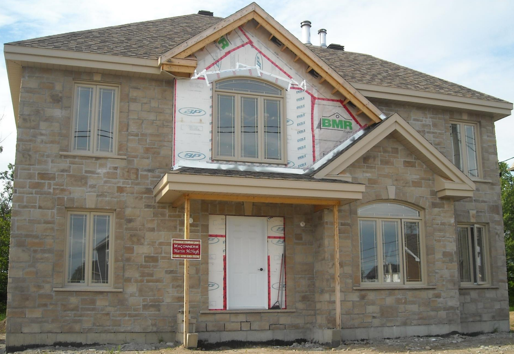
Casa de madera – piedra - Canadá
