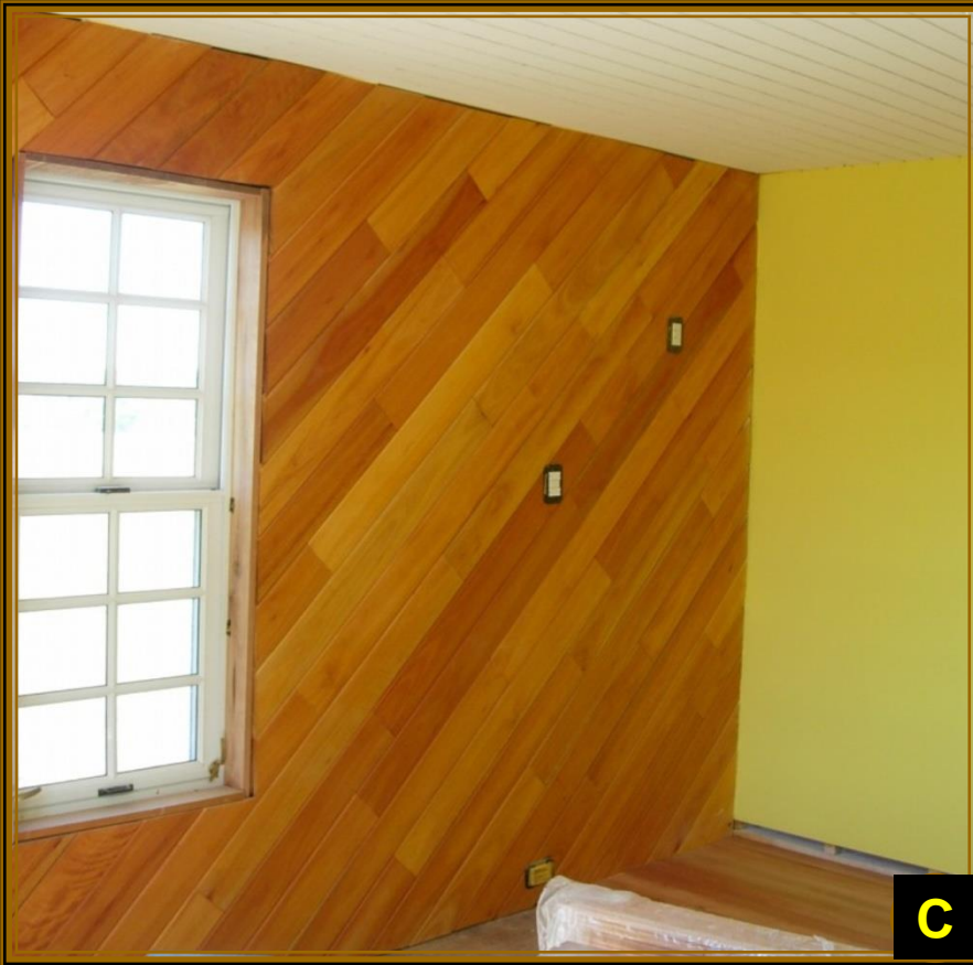
C.- Machimbrado en diagonal (Hab. Princ.)
