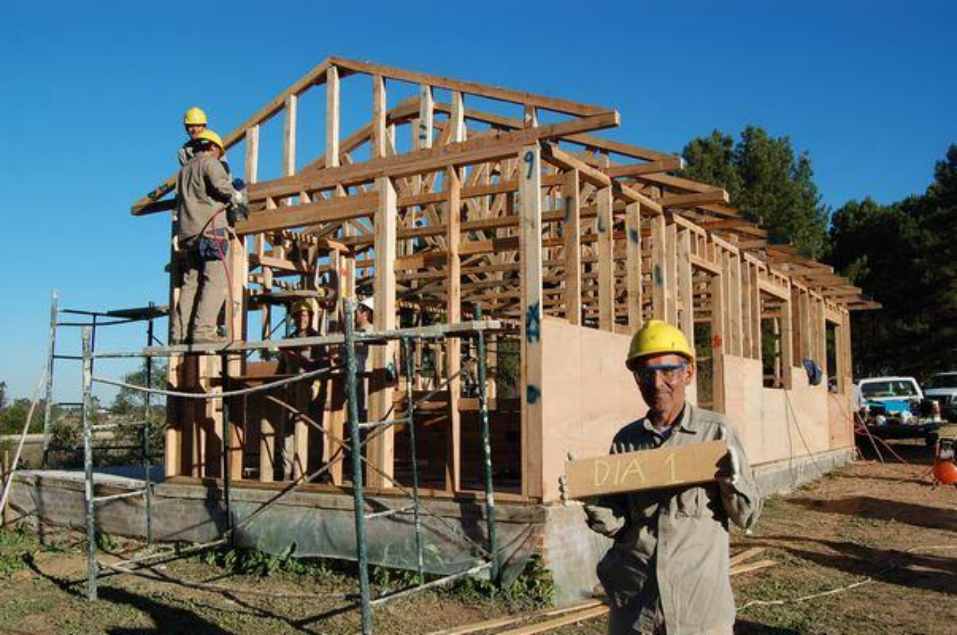
Fin Dia 1 de iniciada la obra
