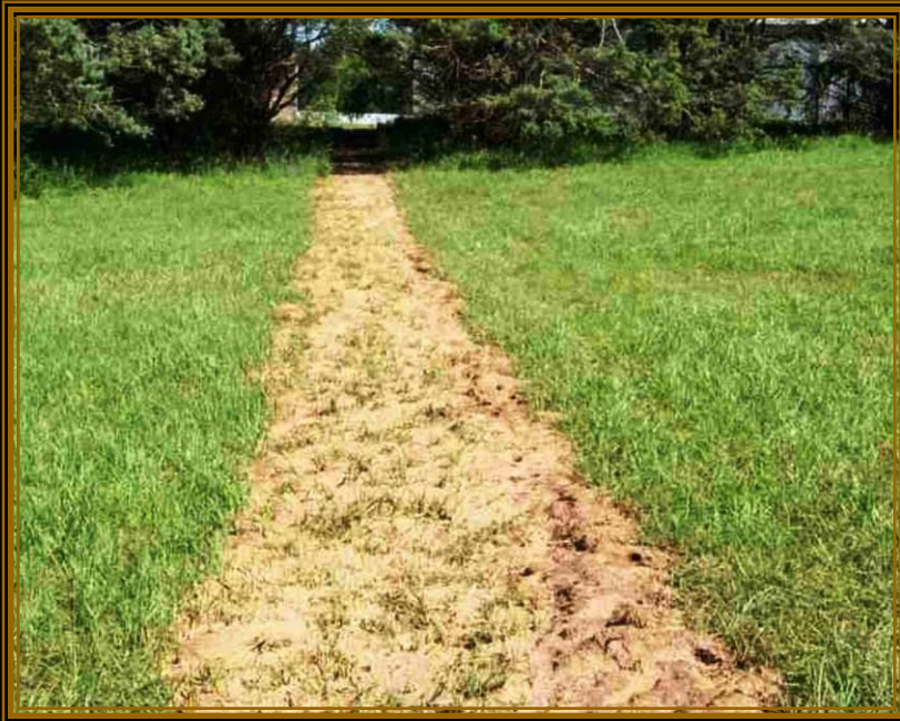
Conexión de agua
