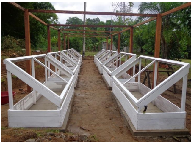
Colocación de cámaras de subirrigación en vivero
