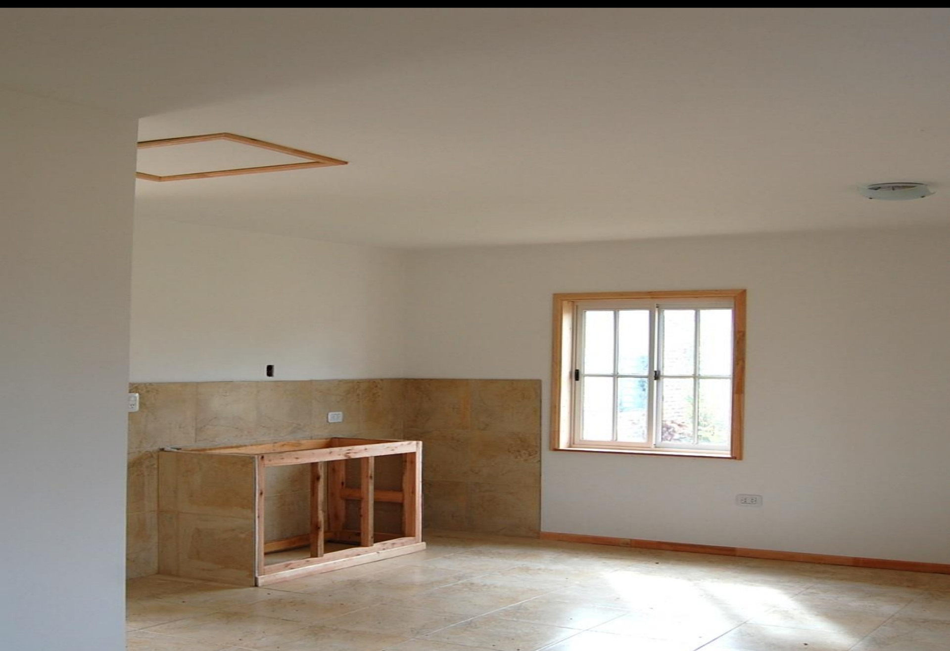
Cocina comedor terminada con yeso y cerámico
